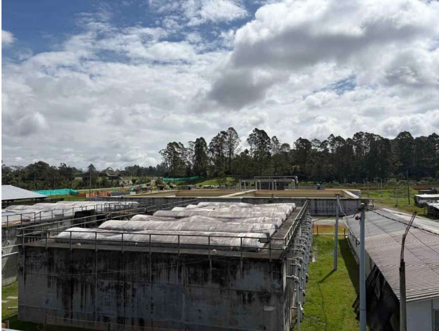
Figura 4. Nota. Registro fotográfico del 21 de abril de 2026, Reactores UASB de la PTAR Tranvia.
