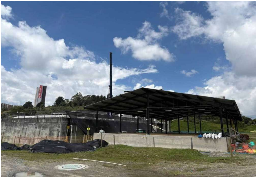
Figura 5. Registro fotográfico del 21 de abril de 2026, Tratamiento deshidratación de lodos PTAR Tranvia.
